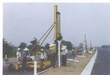
正在进行防撞护栏施工
