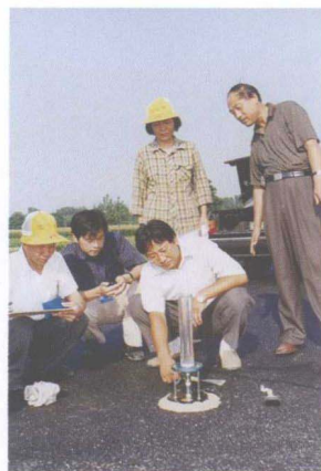
监理正在进行路面透水试验
