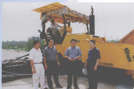
商开公司董事会全体成员在施工现场共同研究施工方案
