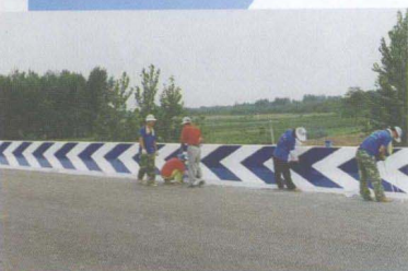
正在进行标志标线施工
