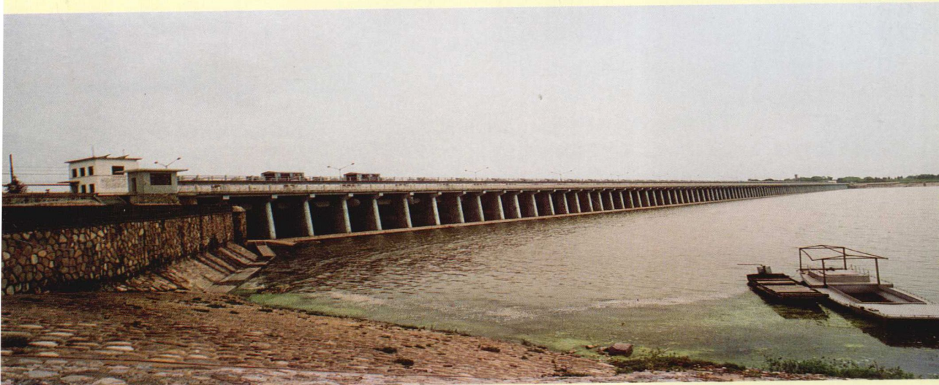
淮河最大的蓄控工程三河闸
