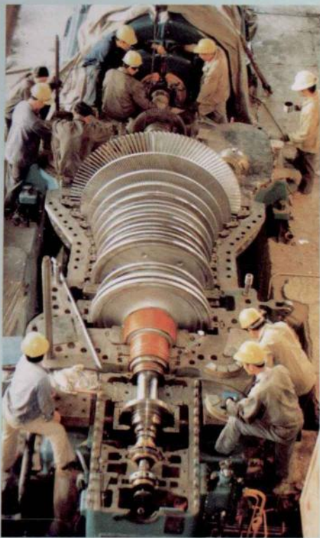
1.2 万千瓦汽轮发电机组安装现场
