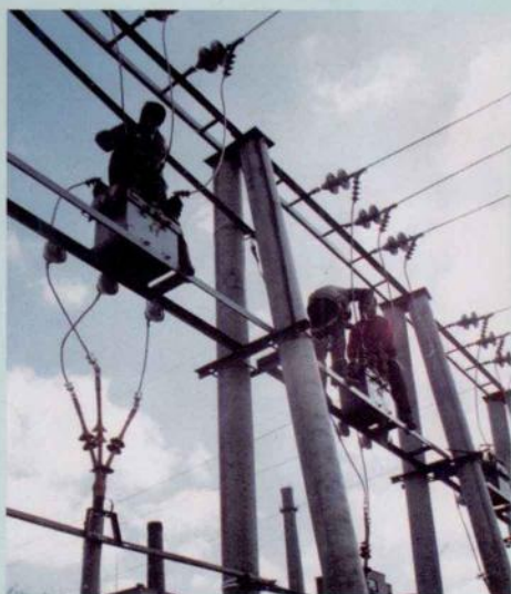
输电线路检修
