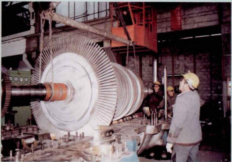
1.2 万千瓦汽轮机转子吊装就位
