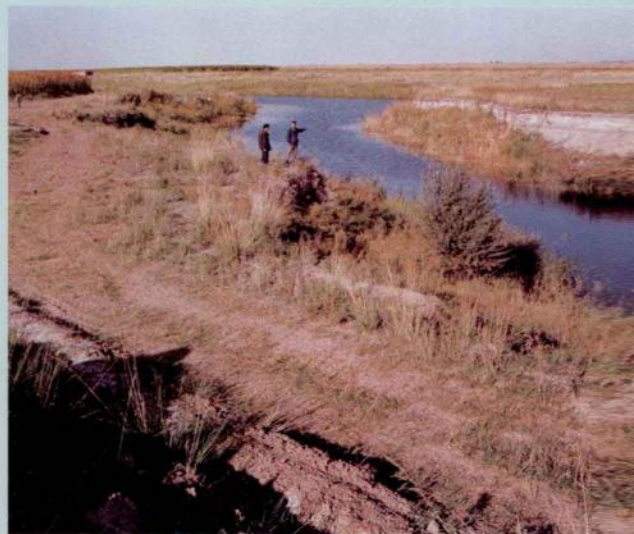
奎屯第一座水电站在这里诞生
