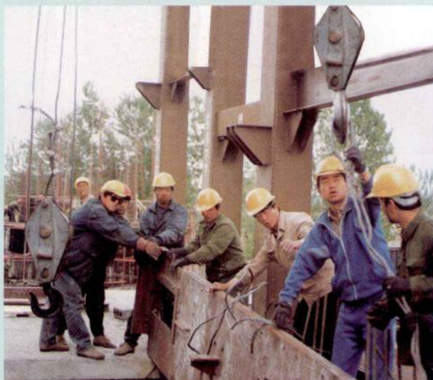
华能火电设备安装工程公司安装 75 吨 / 时锅炉钢架吊装
