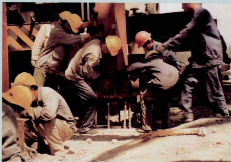
75 吨 / 时锅炉钢架就位
