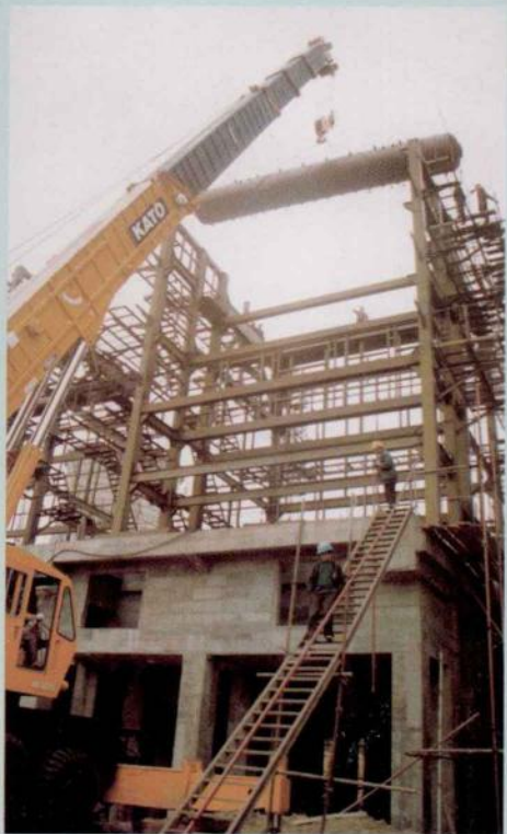
75 吨 / 时锅炉汽包吊装就位
