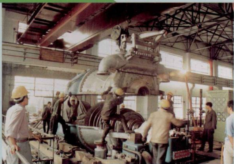
1.2万千瓦汽轮发电机组检修
