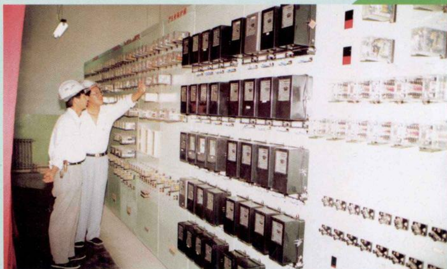
华能火电设备安装工程公司安装调试发电保护装置
