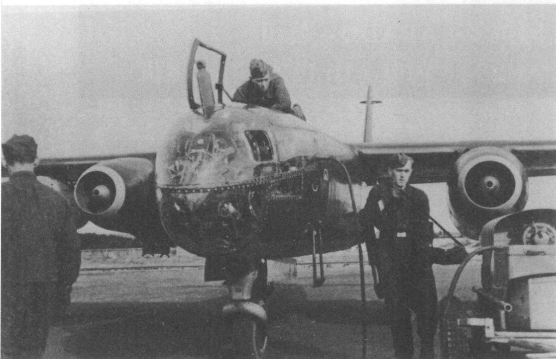
上图：Ar 234B-2飞机的功能远远超过了其前一代机型Ar 234B-1的功能，可以执行轰炸、导航或侦察任务。该机型在发动机短舱的外侧装备了Rauchgerate（烟设备）公司的起飞助推火箭。
