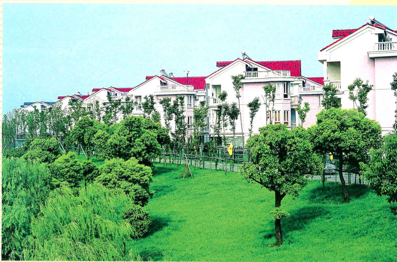
▲ 为尽快改变农村落后社区的面貌，浙江从2003年起实施“千村示范、万村整治”工程。图为义乌市江东街道桥东村旧村改造后面貌焕然一新
