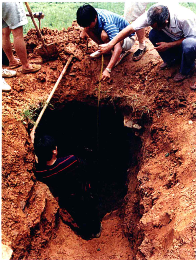
三岔口水库大坝黑翅土白蚁主巢 挖掘现场（舞钢市，2000.7）
