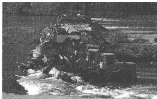
图 1-2 甘肃岷县铁索桥垮塌
