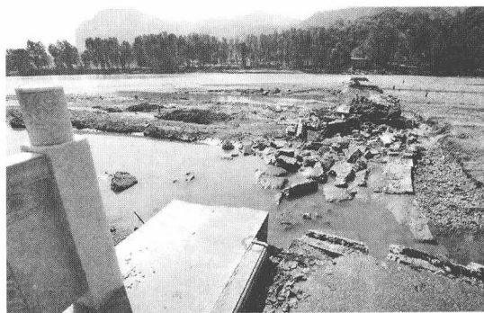
图 1-8 河南栾川大桥遇洪水垮塌
