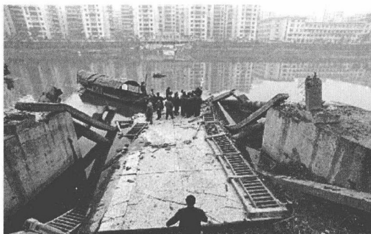
图 1-1 重庆綦江彩虹大桥垮塌
