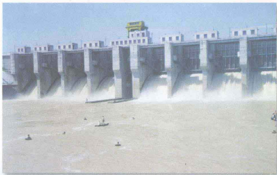
板桥水库闸门
