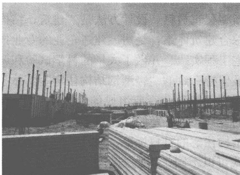
图8 钢结构安装
