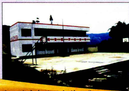
印江试点新建的新村小学
