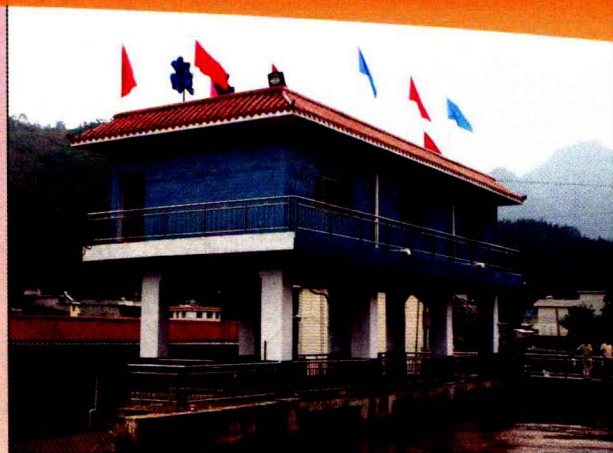
普安县三板桥代燃料电站
