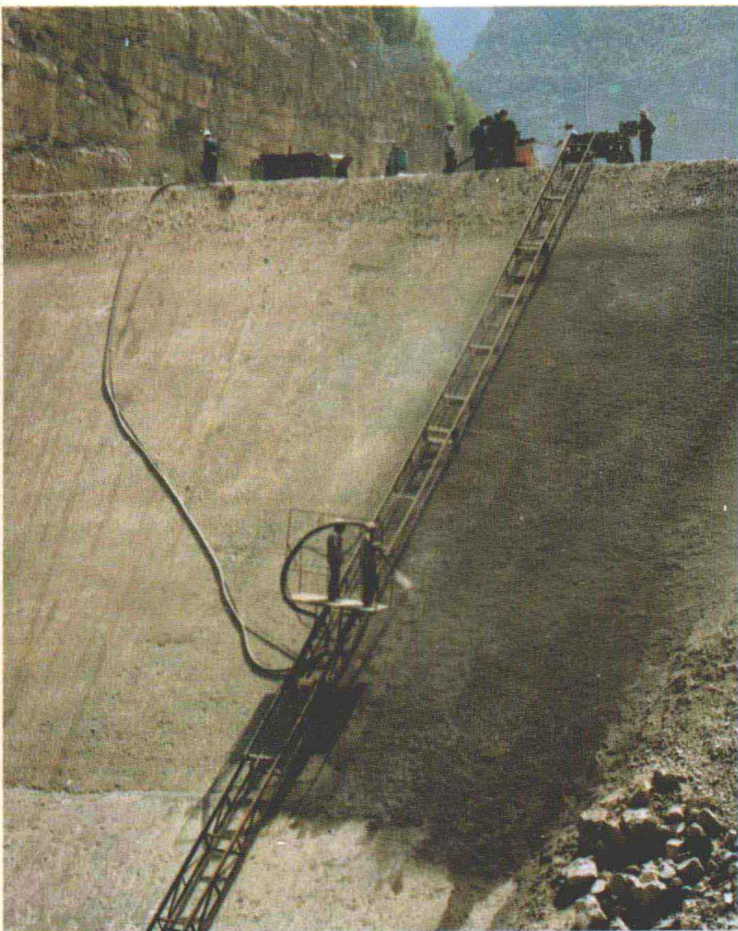
▲ 西北口面板堆石坝上游垫层坡面喷射混凝土
