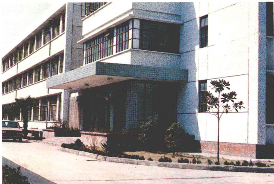
▲ 实验大楼外景
