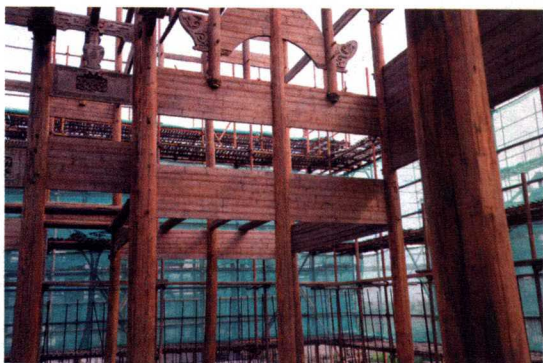
(c) 穿斗式梁架 (施工中)
