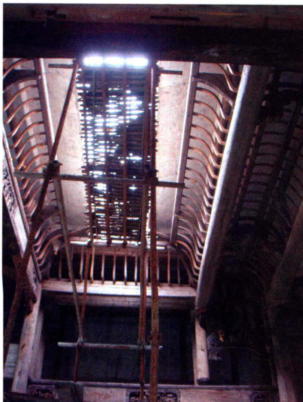
(d) 徽派建筑内天井檐口交汇施工中
