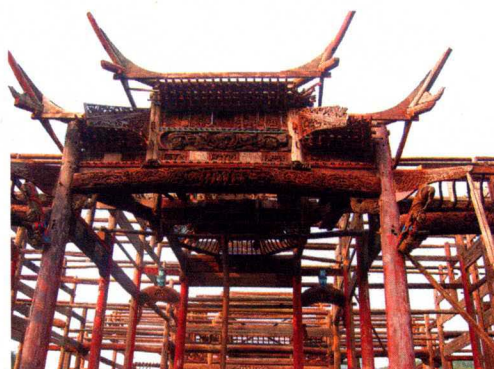
(f) 五凤楼梁架施工中
