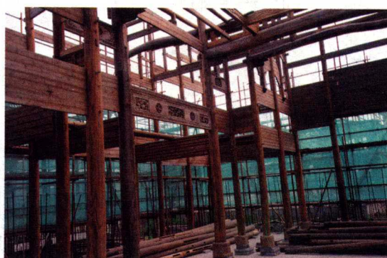
(c) 穿斗式梁架 (施工中)
