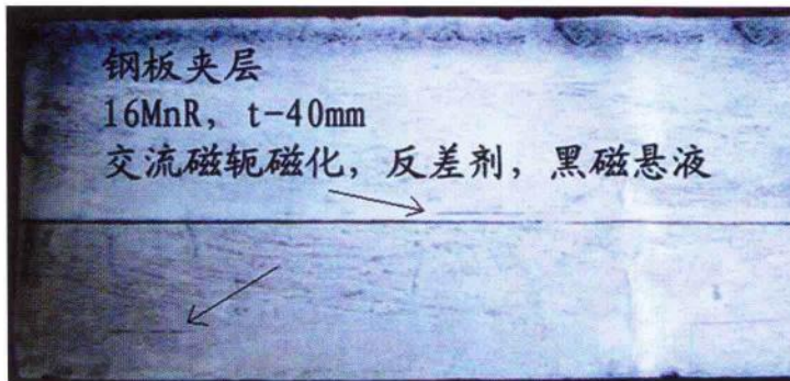
图 105 钢板分层 (黑磁粉检测显示) [6]
