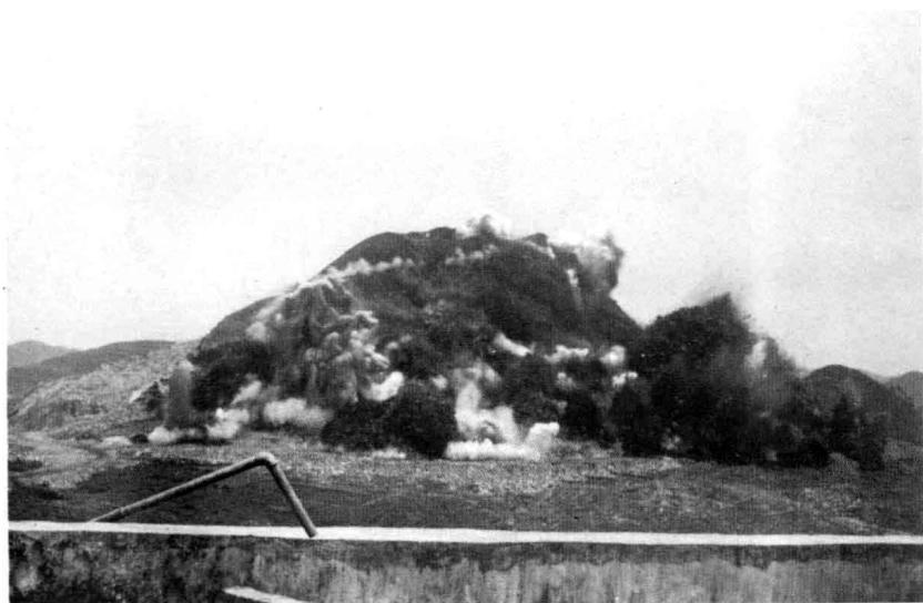
洞室爆破起爆的一瞬间之二
