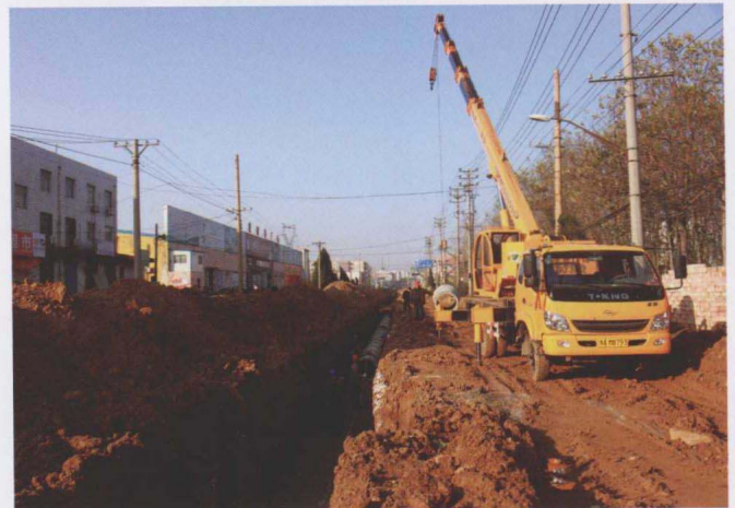
玉发大道升级改造项目开工建设
