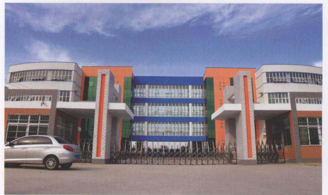
实施中小学校舍安全三年工程。图为异地重建的安阳路小学
