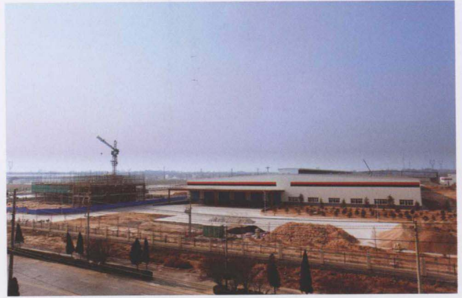
正在建设中的标准化厂房
