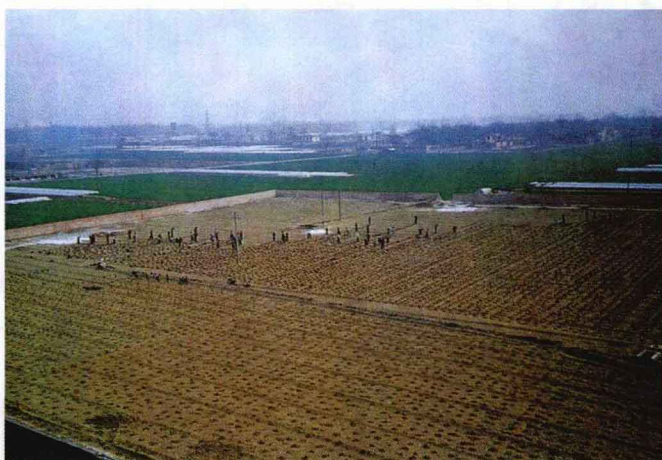
大面积钻探工地
