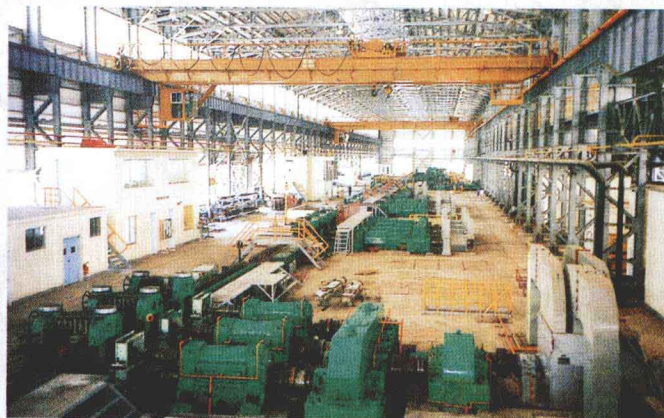
洛阳矿山机械工程设计研究院棒（线）轧钢厂成套工程设备
