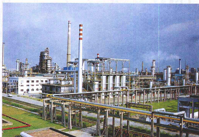
1997年6月，由洛阳石化工程公司总承包建设的国内最大规模的茂名石化公司200万吨/年渣油加氢处理装置在茂名石化公司建成
