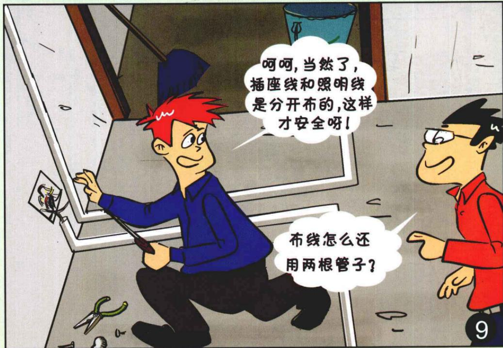
▲ 家庭装修应找电工布线。插座线、照明线最好分开走。电线穿管埋设不仅安全而且便于检修、更换。
