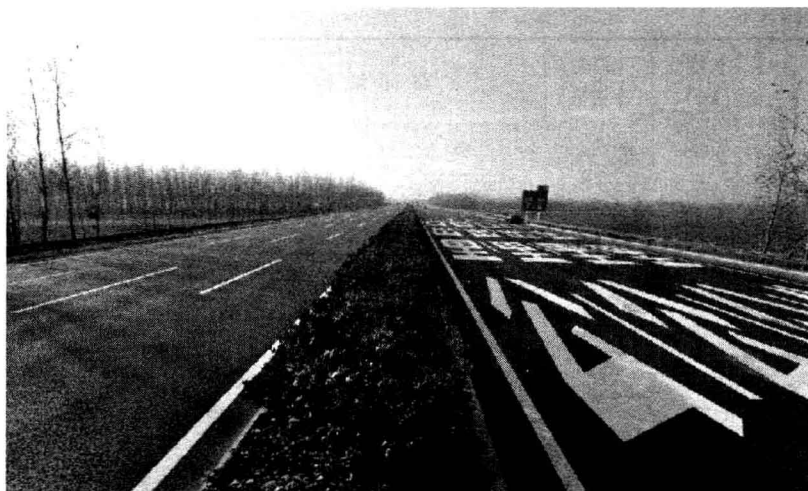
图 1-2 陕西第一条 4 车道改 8 车道 SMA 路面——潼关至临潼高速
