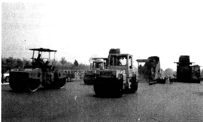
图 1-3 正在摊铺的 SMA 路面
