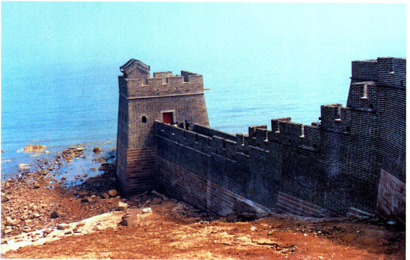
三 修复后的入海石城及敌台——明蓟镇长城第一台（由北向南，1990年11月）
