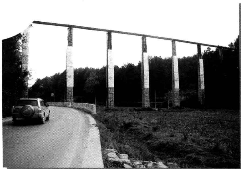
图 -38 1978 年修建的百羊坝排架肋拱渡槽
