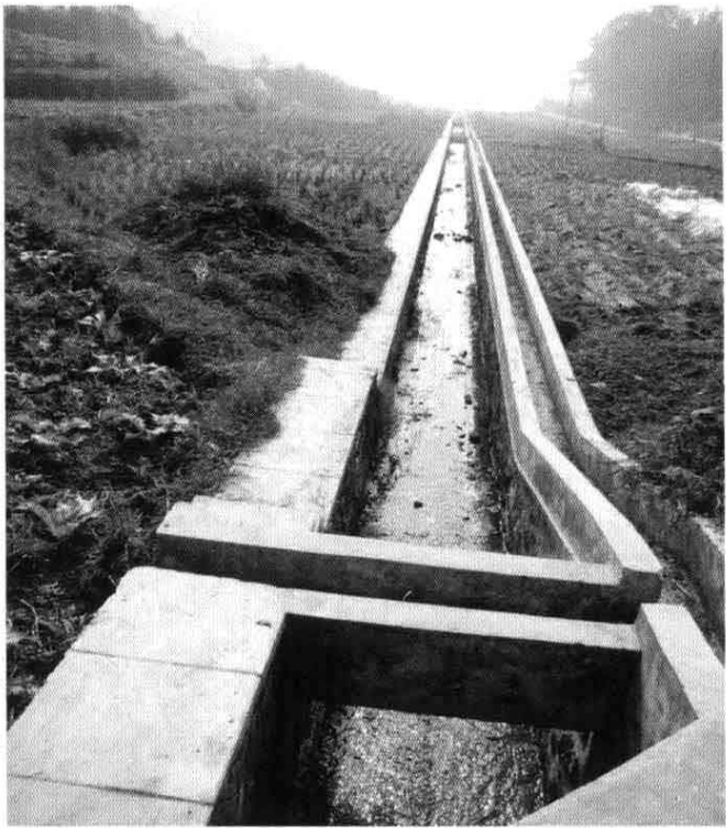
图-42 2006 年建成的排涝水沟
