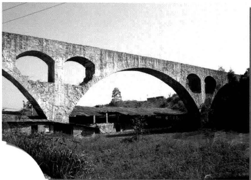
图 -36 1975 年修建的两路口石拱渡槽
