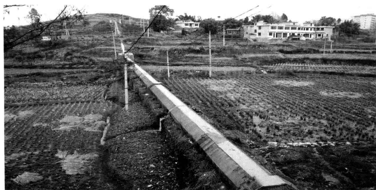
图 -38 1978 年修建的百羊坝排架肋拱渡槽
