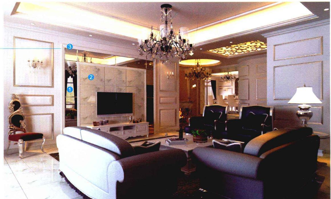
» 在电视背景墙面上弹线放样，用点挂的方式将爵士白大理石固定在墙面上。用木工板在贴银镜处打底及作出收边线条，整个墙面满刮三遍腻子，用砂纸打磨光滑，将成品线条固定在墙面上，刷底漆、面漆；用玻璃胶将银镜固定在底板上。
