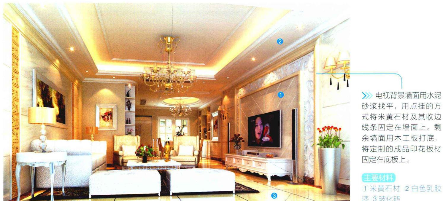
» 电视背景墙面用水泥砂浆找平，用点挂的方式将米黄石材及其收边线条固定在墙面上。剩余墙面用木工板打底，将定制的成品印花板材固定在底板上。
