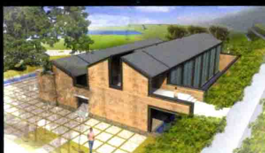
安吉农村生活污水处理展示馆·浙江
