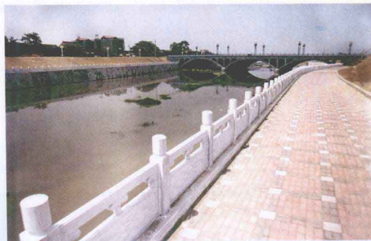
正在治理中的湫河堤岸工程
