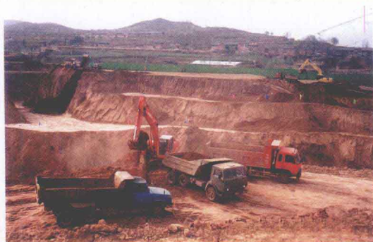
如火如荼的垃圾处理场土方工程建设
