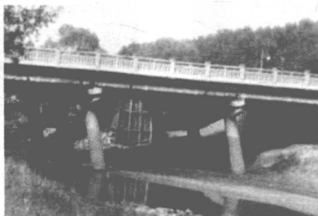
图 1-2 1~3 号墩柱平行向河心倾斜滑移
