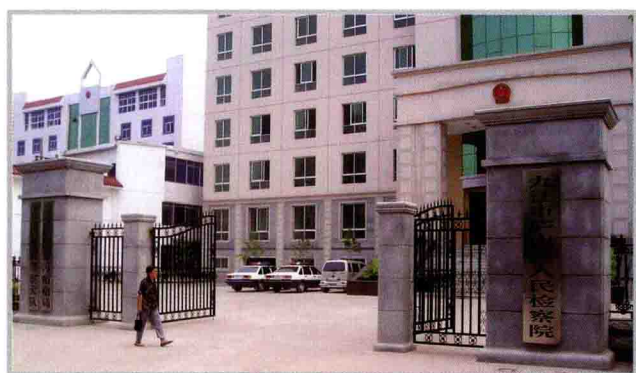
区人民检察院办公大楼
