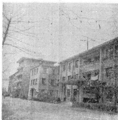
人 民 医 院 建 筑 群
