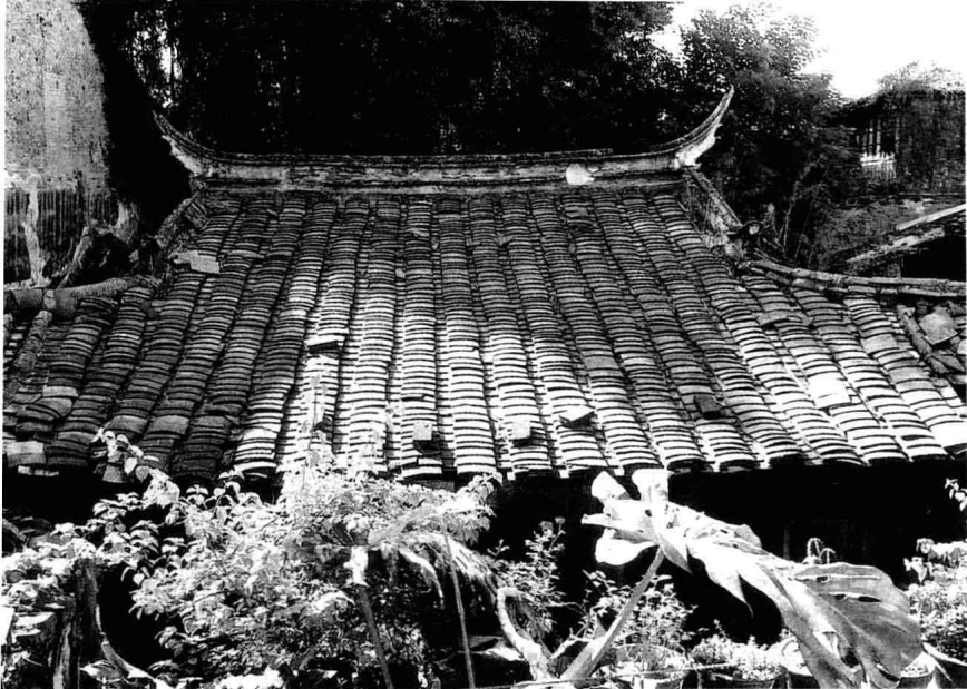
宫巷林聪彝故居花厅的瓦面
