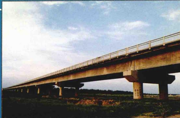
武陟詹店公铁立交桥
