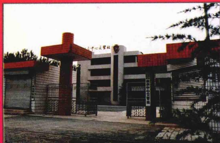
济源苗店「四合一」中心交管站
