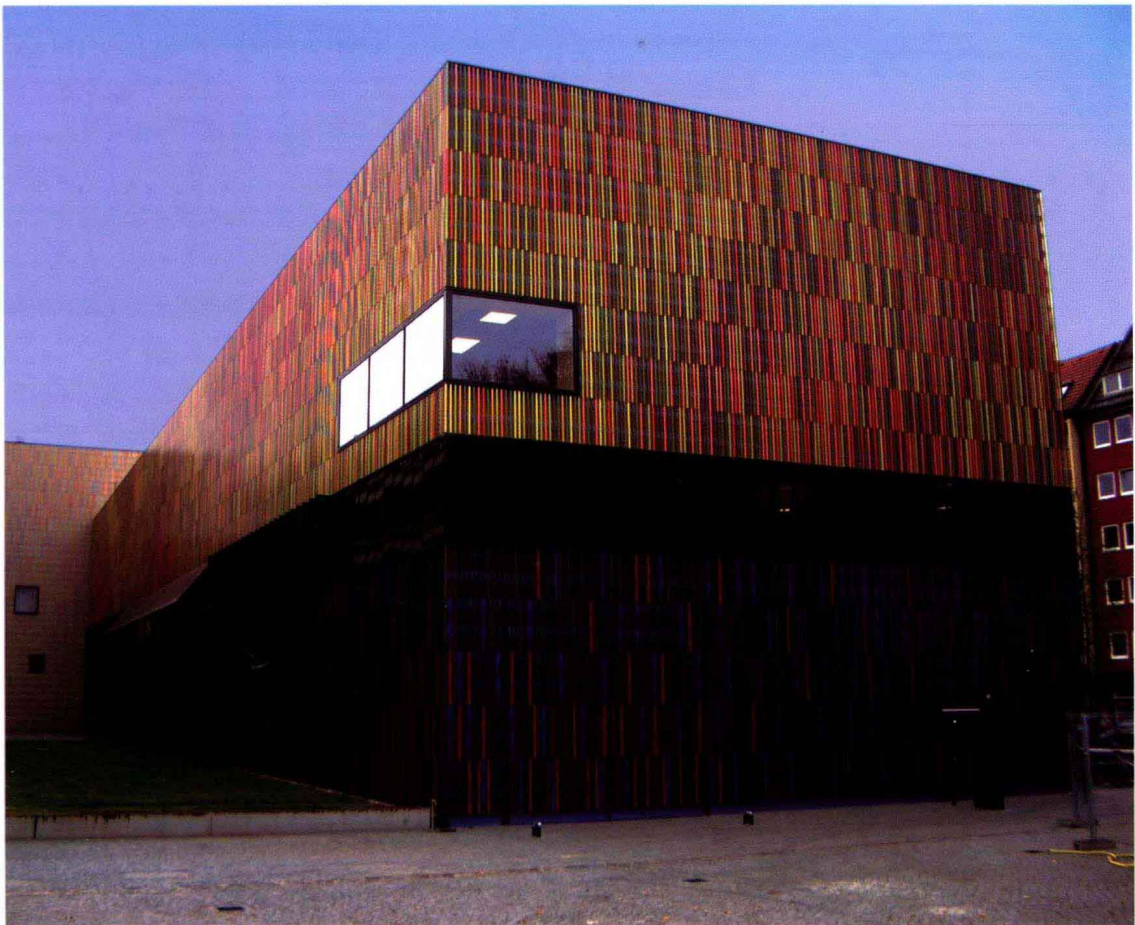
图 3 慕尼黑 Brandhorst 美术馆 Sauerbruch Hutton
