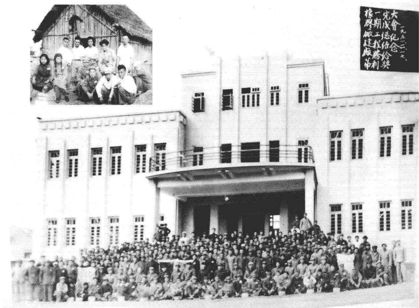
1950年12月，中南军区后勤部由苏联技术指导在岳阳筹建军需生产基地，经过几年发展，建立了境内第一家国营大型企业——211厂（现3517厂）。图为建厂时的部分创业者及1951年建成的该厂苏式办公楼
