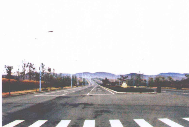
开发区道路建设
