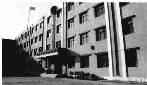
中铁十八局子弟学校教学楼
