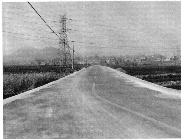
新建 21 公里修建的镇村道路
