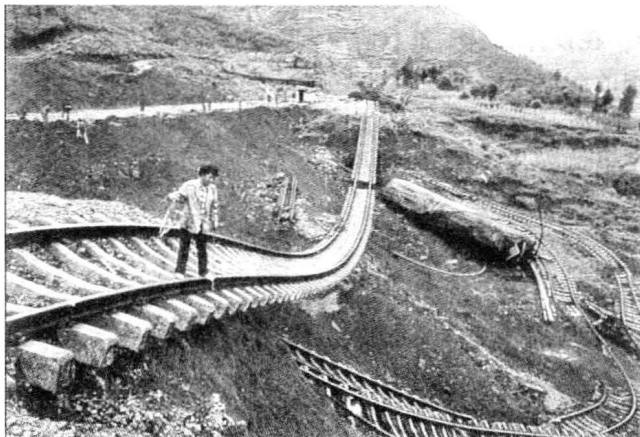
图 1-5 滑坡地段铁路受毁
