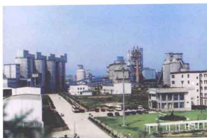
豫鹤水泥厂全景
