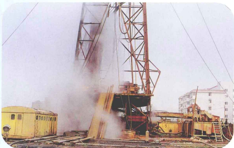
新区施工的深层地热井深3276米，具有强烈的水气喷发现象，井口自喷热水1847米 3 /d，水温74℃，同时喷出CO 2 气体27705米 3 /d。
