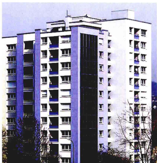
图 2-15 太阳能热水系统建筑一体化实例 11
