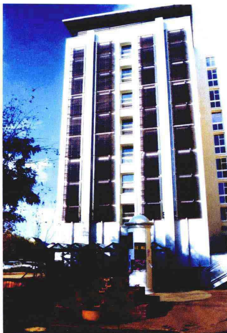
图 2-12 太阳能热水系统建筑一体化实例 8
