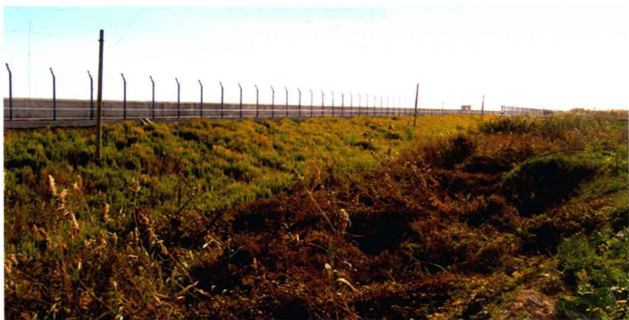
示范地东侧排水沟
