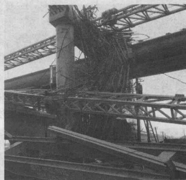
图 1-11 墩、梁支架中贝雷梁支架局部杆件失稳造成支架沉降
