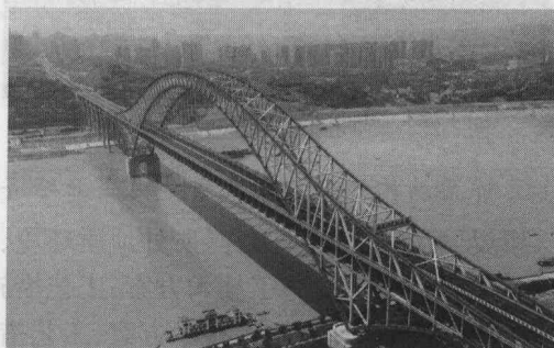
图 1-32 重庆朝天门大桥
