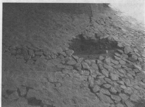
图 1-25 某桥桥台锥坡破损情况
