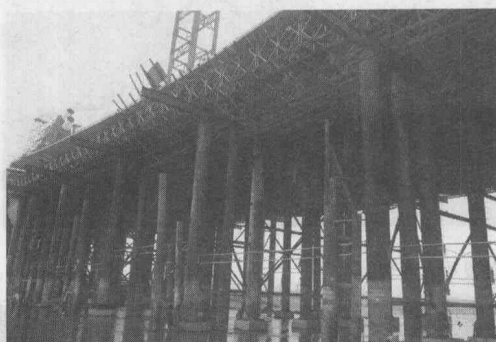
图 1-11 墩、梁支架中贝雷梁支架局部杆件失稳造成支架沉降
