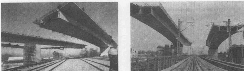
图 1-3 平转施工桥梁转体中的悬臂结构
