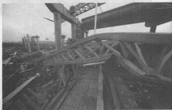
图 1-12 某桥梁桥机坠落事故
