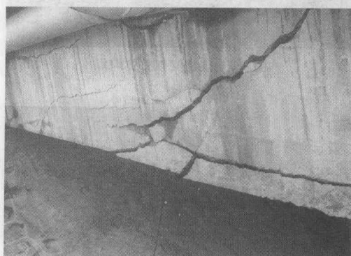
图 1-13 混凝土表面崩裂及表面裂缝
