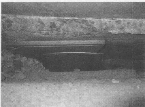
图 1-20 橡胶支座从设计位置滑出
