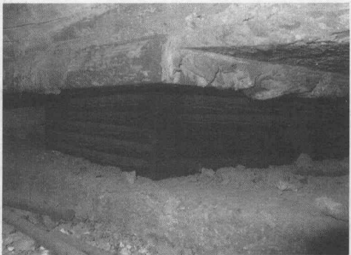
图 1-22 橡胶支座破损、外鼓情况
