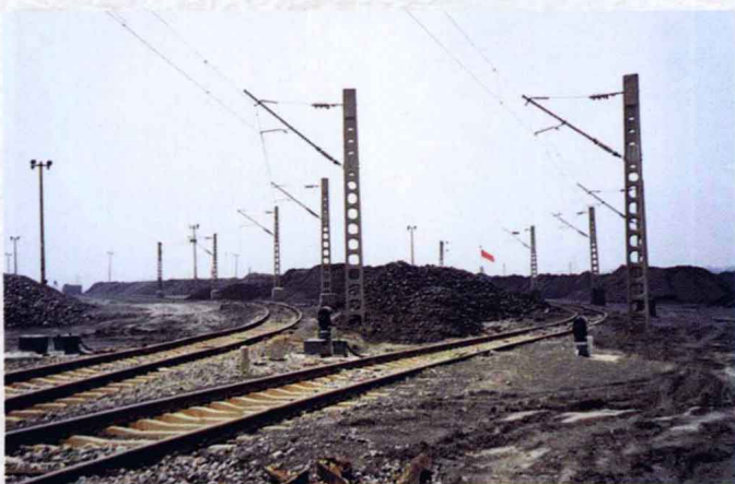
煤炭铁路运输线
