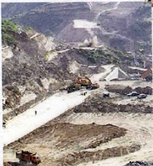
济源高速施工现场
