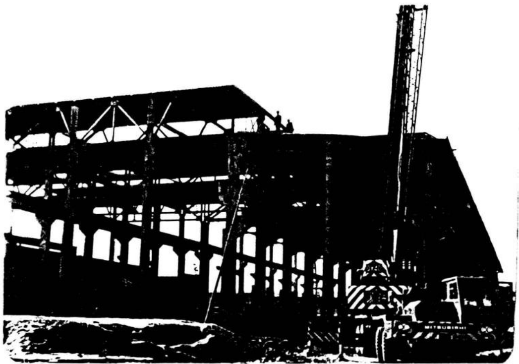
建设中的新厂
