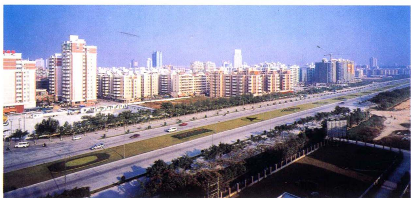
新建的新城大道
