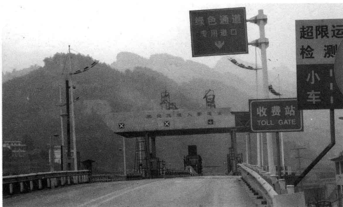
渝湛高速路太白站
