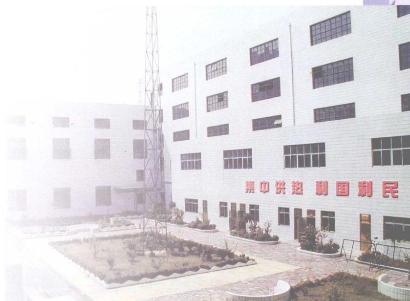
现代化的热力厂一角
