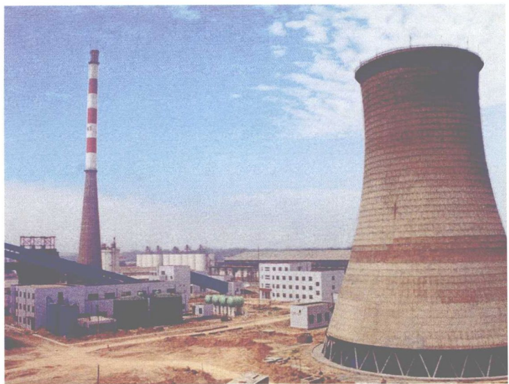
建设中的兴隆铺热电厂初具规模
