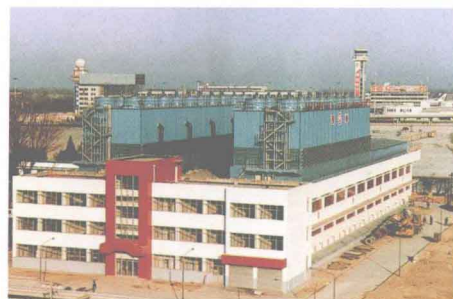
北京首都机场溴化锂 450万大卡×9台集中制冷 站安装调试
