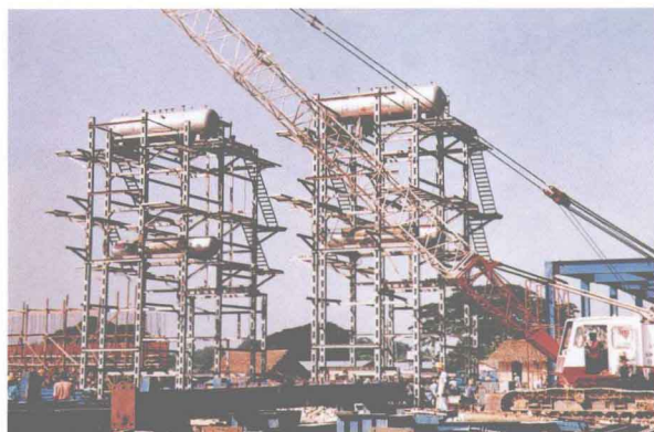
缅甸同辛埃糖厂 1500T/日设备安装调试
