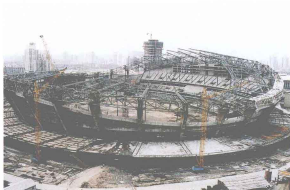
上海8万人体育场钢结构焊接工程
