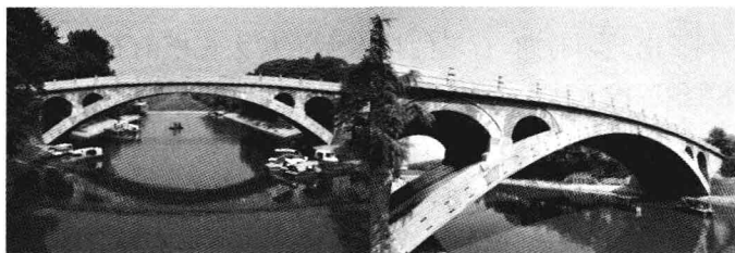
图 1.6 河北赵县安济桥
