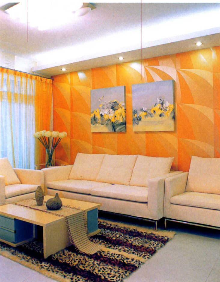
轻钢龙骨石膏板吊顶
