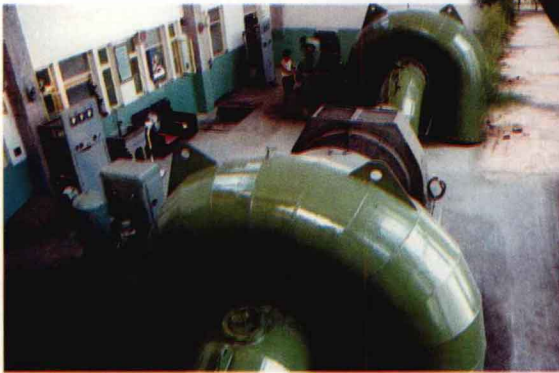
彰武水库发电机组
