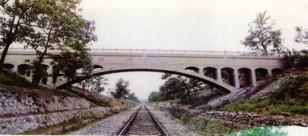
安阳县跃进渠渡槽
