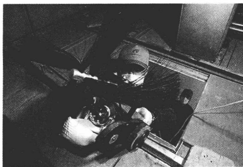
图 1.2 管道移动机器人被送进人民大会堂空调管道
