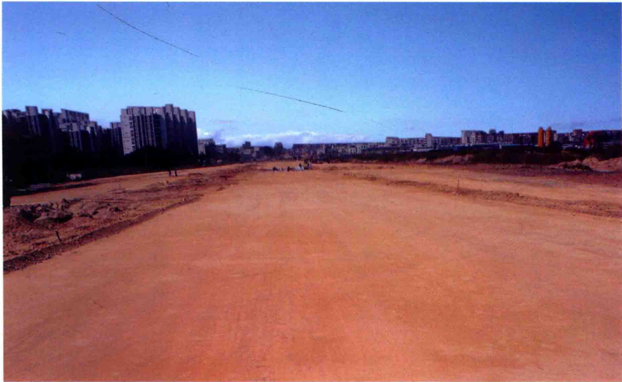
图1.1.1 土基表面平整、无积水现象
