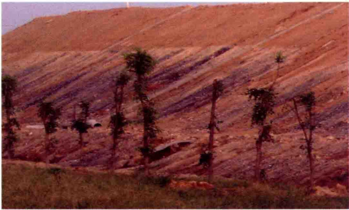
图1.1.3 道路路肩 (密实、无松散、滑坡现象)
