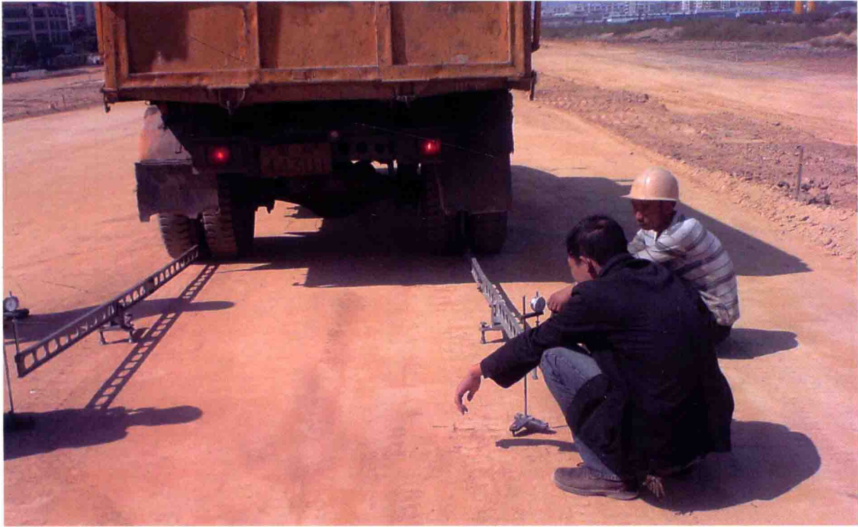
图1.1.2 路基弯沉检测
