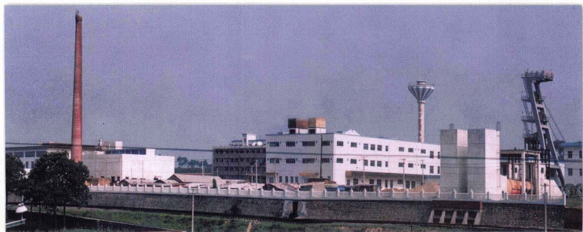
▲ 正在建设中的梁北一号矿井
