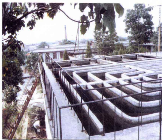
◀ 中峰吕沟煤矿的污水净化系统
