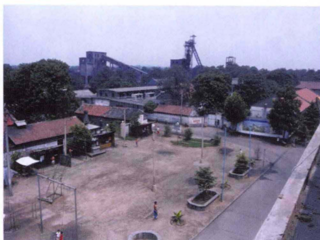
新峰矿务局 一矿工业广场
