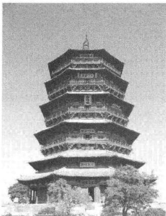
图 1-3 山西应县木塔
