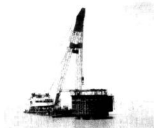
图 1.19 深水承台套箱施工
